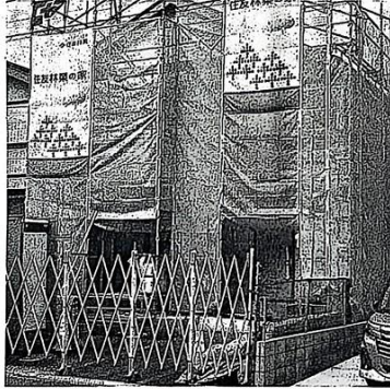
新築住宅は土地価格や建築費高騰で庶民の夢から遠ざかっている。
